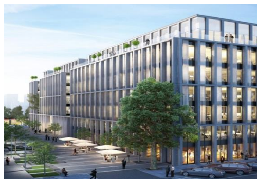
Biurowiec Nowogrodzka Square, Warszawa, systemy wentylacji pożarowej
