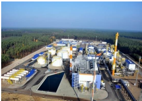
Kopalnia Gazu Ziarnego LMG dla PGNiG, ogniocbronne zabezpieczenia konstrukcji
