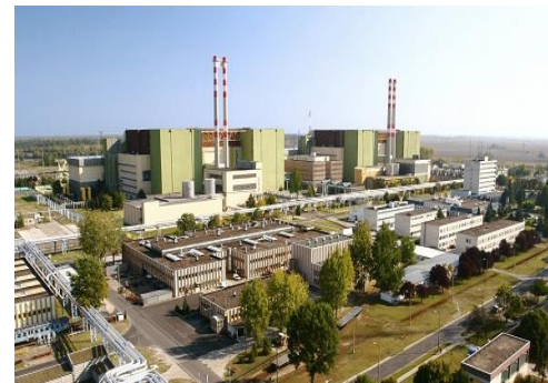
Elektrownia atomowa w Paks, Węgry, ogniocbronne zabezpieczenia konstrukcji
