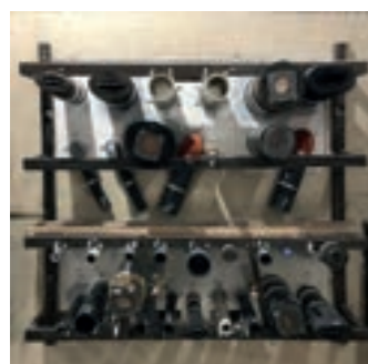
» przeprowadzenie instalacji w bloczkach SAFETY BLOC
