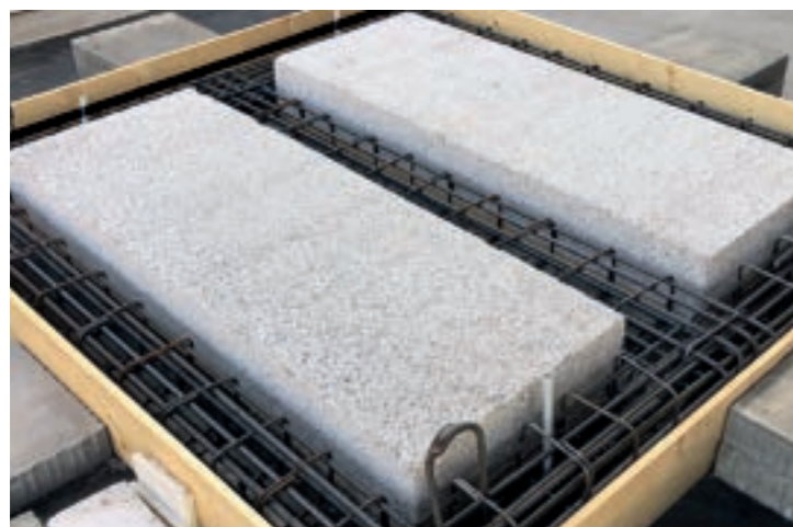
» osadzenie bloczków SAFETY BLOC w stropie
