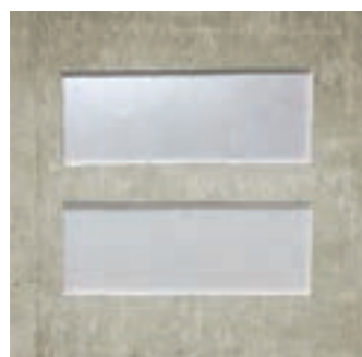
» osadzenie bloczków SAFETY BLOC w stropie
